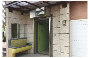
感恩樓一樓廁所整修—完工後
