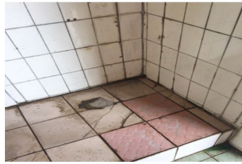
感恩樓一樓廁所整修—施工前
