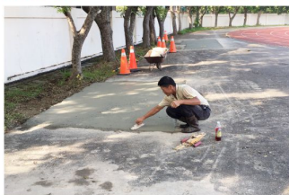
操場旁柏油路修補
